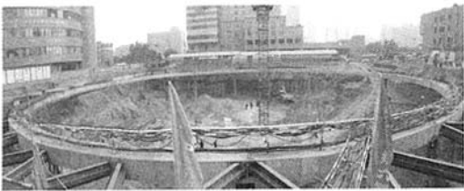
图 1 正在开挖的北京西站地下行包库基坑
