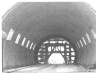
图 2 缓冲结构实体图
