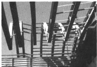
图12 正在施工中的天桥跨弧形檩条局部
