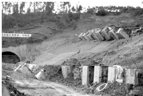
图 3 一、二级边坡倾倒变形桩实物图
