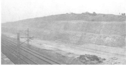
图 4 某复线开挖工程采用深孔预裂爆破成功完成大面积薄层岩体边坡
