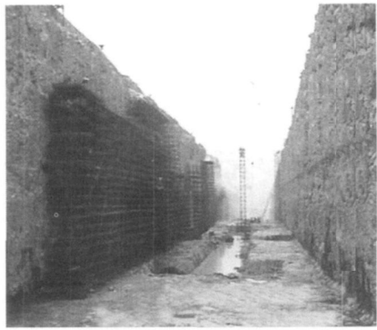
图1 三峡船闸航道工程整齐的预裂壁面
