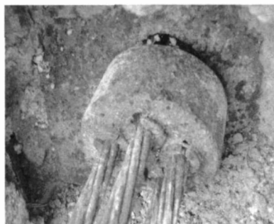
图 4 锈蚀的锚头
