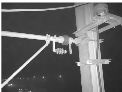
图 9 避雷器安装后
