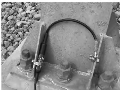
图 8 地电位均衡器安装后
