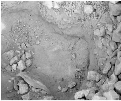
(a) 现场埋置的两布一膜土工布
