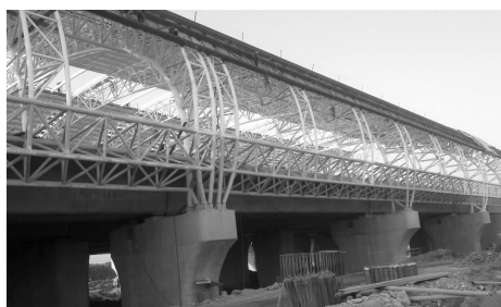
图 1 某高架车站站台雨棚钢管桁架托架结构
