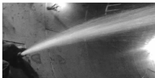
图8 管片开孔地下水喷出图
