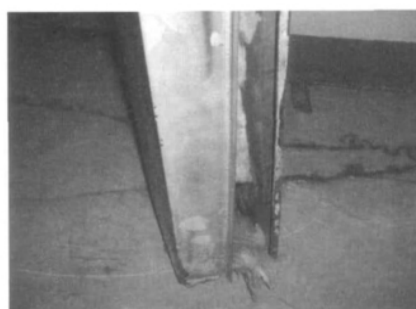
图1 区间防火门门体开裂
