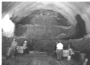
图 2 短台阶七步开挖法
